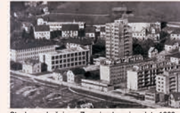
Stavba podružnice in Zagorju, dograjena leta 1962
