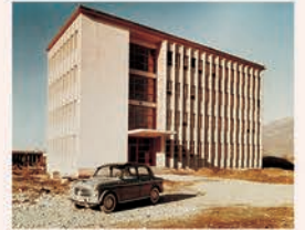
Stavba podružnice v Novi Gorici
