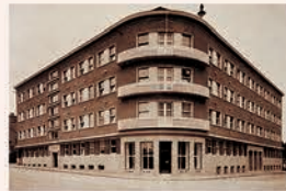
Stavba z ambulatorijem v Mariboru iz leta 1932
